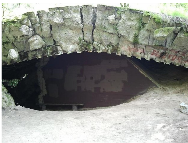
Strzaliny - charakterystyczny strop bunkra.
